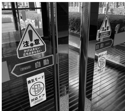
「換気モード」付の自動ドア。隙間を設けることで換気している。
